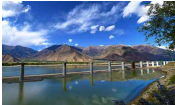
拉林铁路绿色施工
