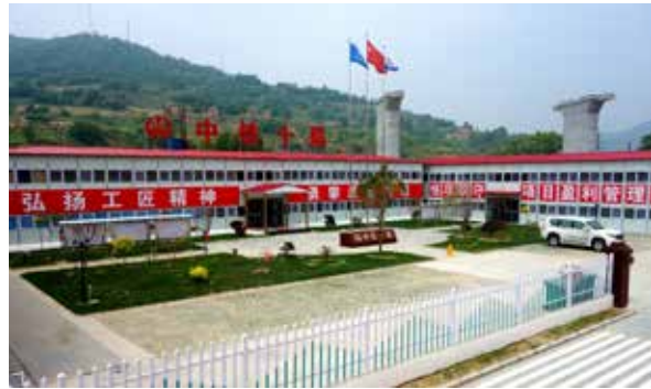
中铁十局蒙华铁路梁场办公生活区
