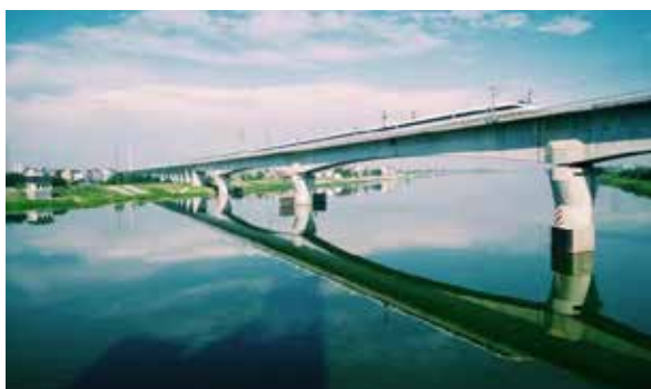
新建杭州至长沙铁路客运专线金华江特大桥
