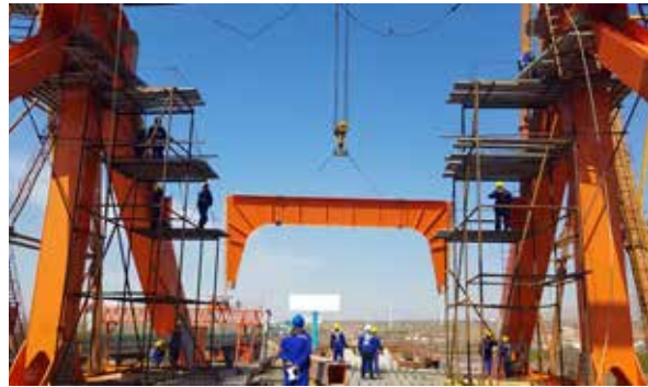
官厅水库特大桥钢梁拼装
