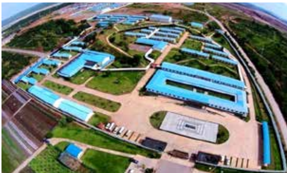
刚果(金)SICOMINES铜钴矿采选冶一期工程
