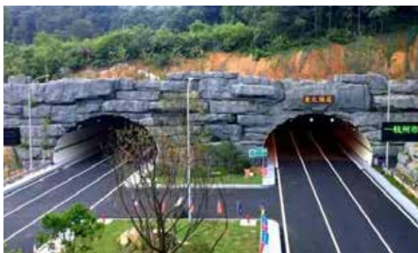
杭州市紫之隧道（紫金港路~之江路）工程
