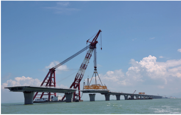
港珠澳大桥架设
