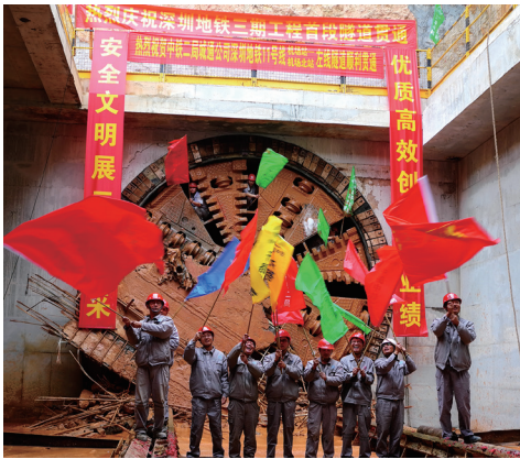
深圳地铁11号线盾构贯通
