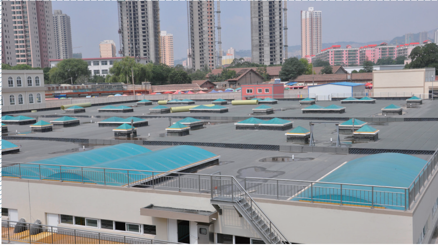
兰州中铁水务公司建成西北地区首家加盖除臭污水处理厂
