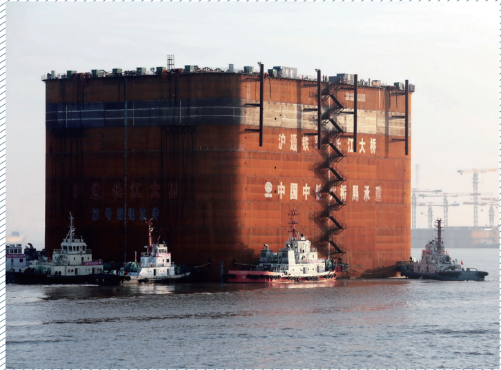
世界最大沉井——沪通长江大桥29号墩
