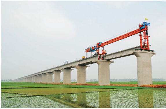
及时完成建设临时用地复垦工作
