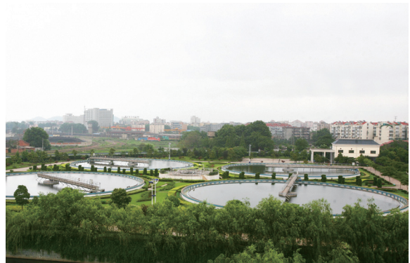
马鞍山中铁水务公司沉淀池
